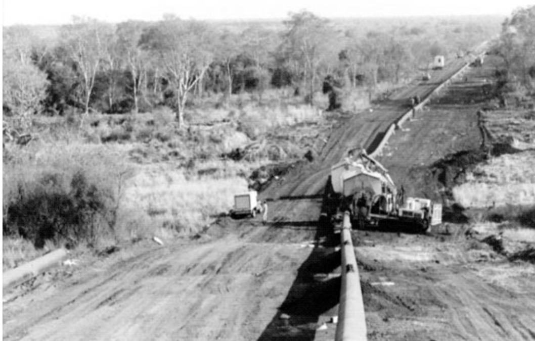
Budowa gazociągu w Mozambiku
