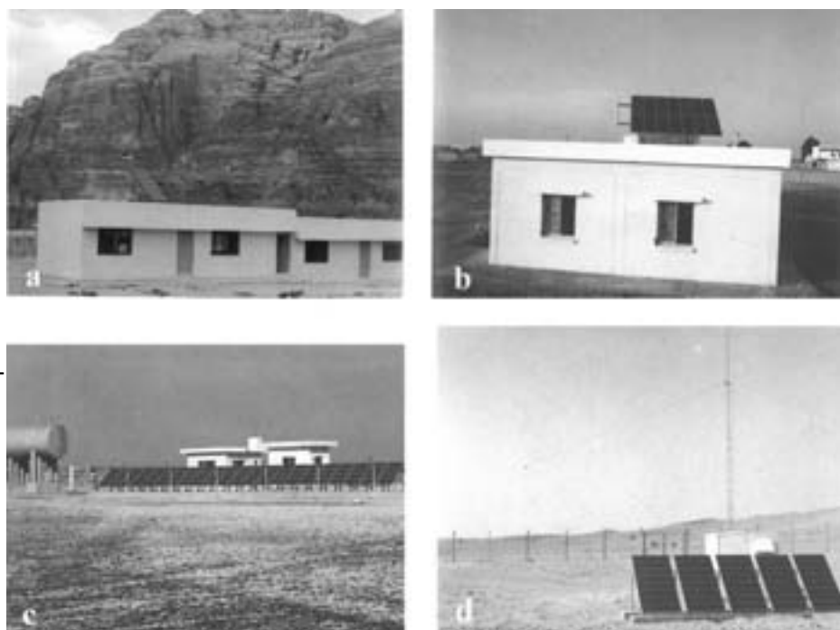
Rys.1.6. Popularne miejsca użytkowania techniki fotowoltaicznej (a, b – w domach; c – do przepompowania wody na pustynie; d – w telekomunikacji)
