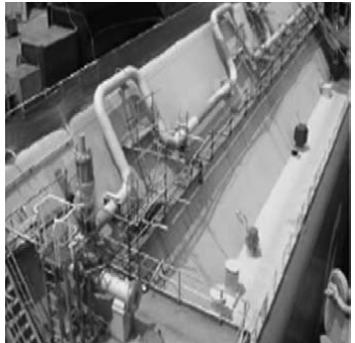
Fot.14. Kolektor wyładowkowy wysokiego ciśnienia na prawej burcie statku.
